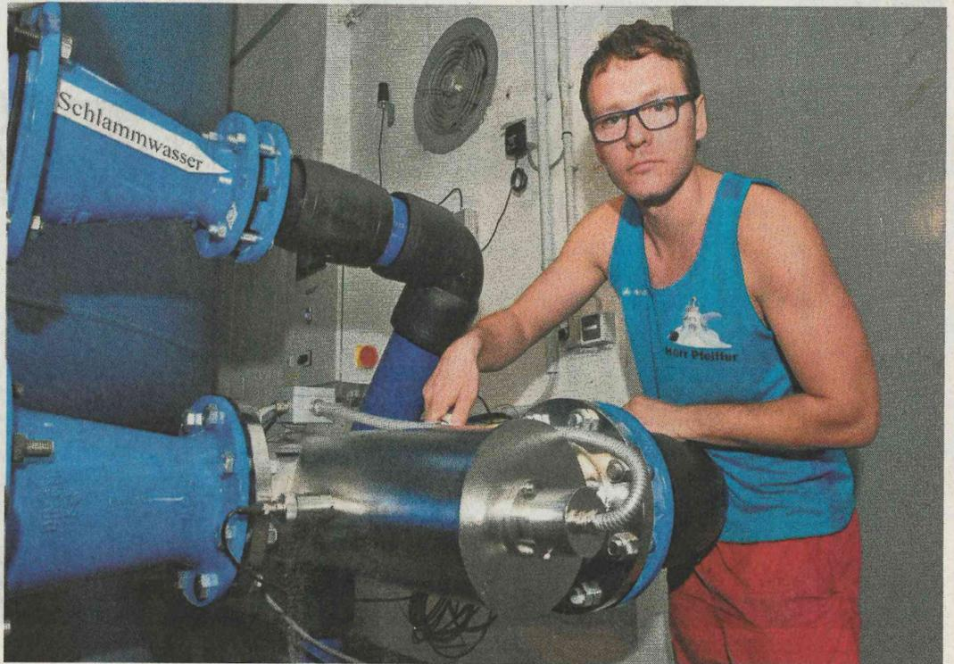
Bäderbetriebs-Meister Jan Pfeiffer zeigt das metallfarbene Einbauteil im Wasserkreislauf im Keller der Schwimmhalle. Dabei handelt es sich um den sogenannten „Reaktor“ mit der eingesetzten 3000-Watt-UV-Lampe, die einen Großteil der Bakterien und Keime im Badwasser abtötet.
